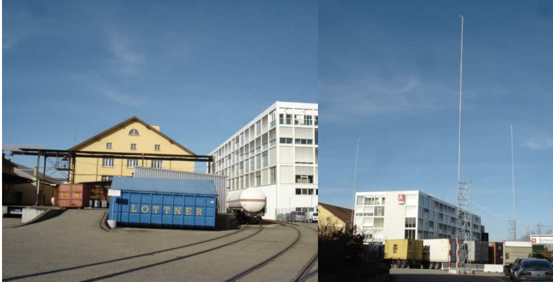
Abbildung 10 : Ansicht Süd TP2 vom zentralen Platz aus
